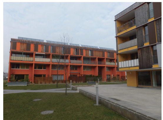
ウィーン郊外にあるCLT造の中層集合住宅
